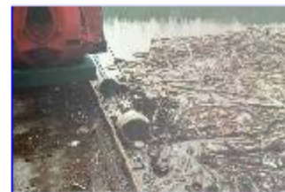
Putzharken (mit Schwemmgut)
